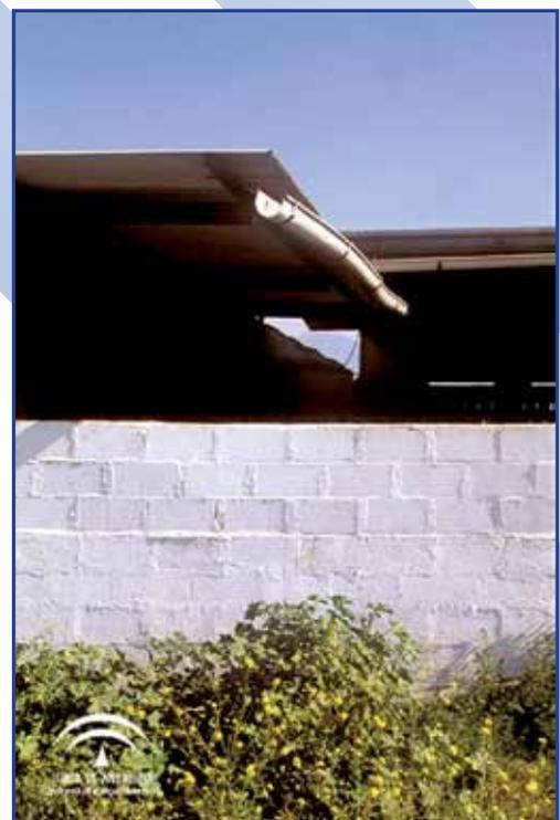
Detalle de un cerramiento de obra realizado con bloques de hormigón.
