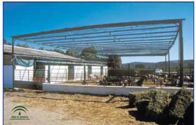
Parque de ejercicio estructura metálica para colocar malla de sombreado en época estival.
