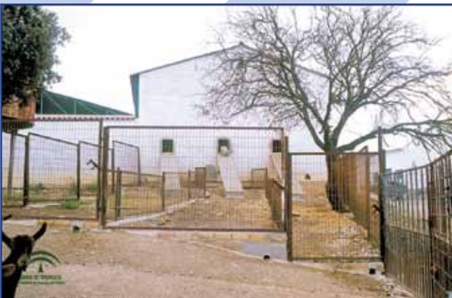
Detalle de cerramiento del área de ejercicio de los lactantes mediante la ejecución de un cercado mixto de cancelas metálicas, con base de obra. Se observa las salidas aguas para mantener seca la solera.
