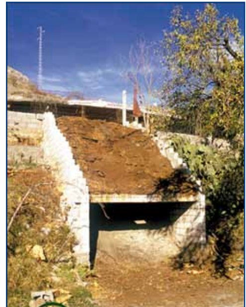
Sistema de almacenamiento de estiércol en pequeña explotación caprina aprovechando desnivel del terreno.
