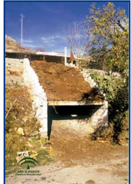
Estercolero en el exterior de una nave de ganado caprino en Almería. Se ha aprovechado el desnivel del terreno para una mejor gestión del mismo, cargándose los remolques por la parte inferior
