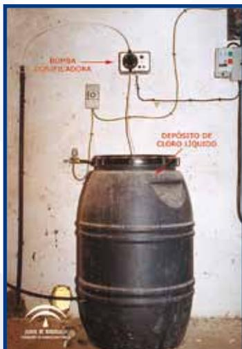
Dosificador de impulsos eléctricos y su unión al contenedor de cloro líquido
