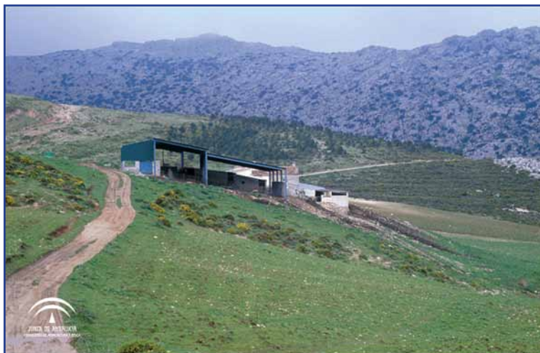
Foto 1. Se puede observar en esta explotación como se aprovecha la pendiente del terreno para la ubicación de las diferentes dependencias. Además se ha ubicado por debajo de la línea del horizonte reduciendo su impacto visual.
