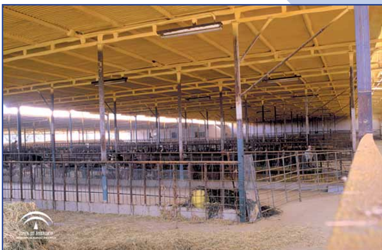
Foto 2. Aislante proyectado en cubierta para mejorar las condiciones de aislamiento y de temperatura en el interior de una dependencia para el ganado.
